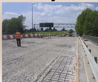
Opravy mostovek na silnicích a dálnicích
