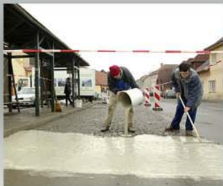
Spárování komunikací, zastávek, kruhových objezdů a dalších ploch z dlažebních kostek a dlažby
