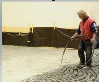
Spárování komunikací, zastávek, kruhových objezdů a dalších ploch z dlažebních kostek a dlažby
