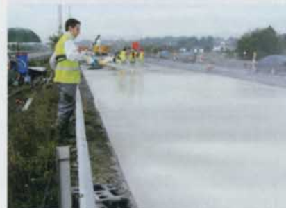
Obr. 10 – Nástřik jemného křemičitého písku na finální povrch malty
