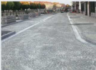
Obr. 7 – Zaspárovaná komunikace materiálem Groutex Pavement
