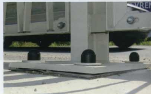
Obr. 1 – Gumová podložka pod patkou svodidla
