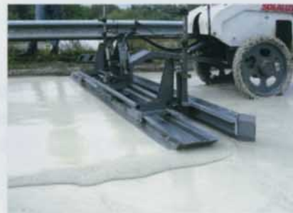
Obr. 9 – Strojové urovnání malty Groutex Profil
