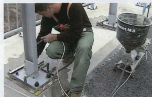
Obr. 2 – Injektáž pod patku záchytného systému
