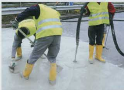
Obr. 8 – Ukládání směsi Groutex Profil pomocí čerpadla
