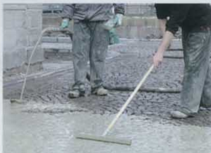
Obr. 6 – Pokládání směsi Groutex Pavement
