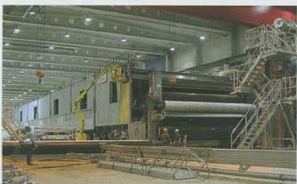
Obr. 3 Ukotvenie a podliatie rozsiahlej strojárenskej technológie
