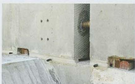
Obr. 6 Chemické debnenie škár pred zmonolitnením prefabrikátov
