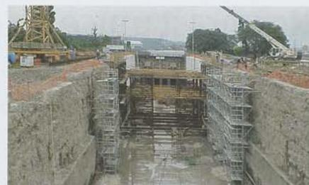
Obr. 4 Kotviace práce pri opravách plavebnej komory
